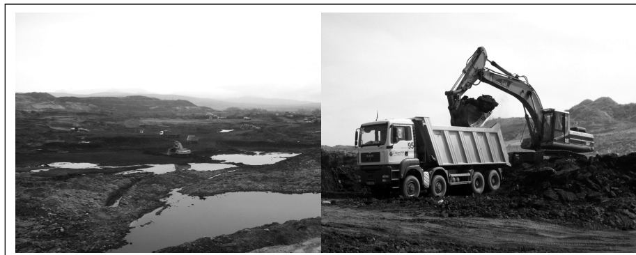
Слика 4 - Панорамски приказ на ПК Брод Гнеотино и циклична механизација Figure 4 - Panoramic view of the OM Brod-Gneotino and the cyclic mechanization
