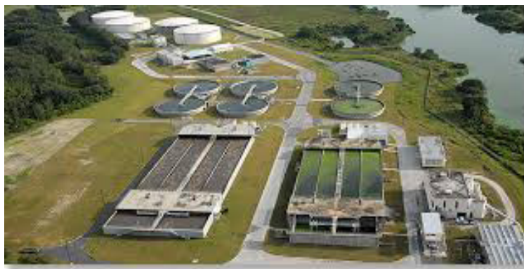
Слика 5. Постројка за третман на отпадни води Figure 5. Wastewater Treatment Plant
