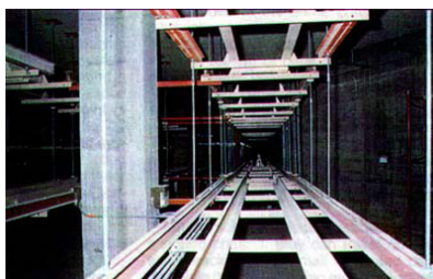
Слика 15. Тунел по кој се движат автоматизираните возила Figure 15. Tunnel for automated vehicles
