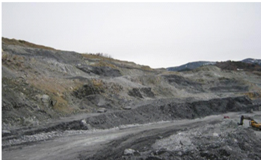
Слика 1 - Појава на свлекување на земјиштето во североисточниот дел од рудникот Figure 1 - Stripping onset of the land in the northeastern part of the mine
