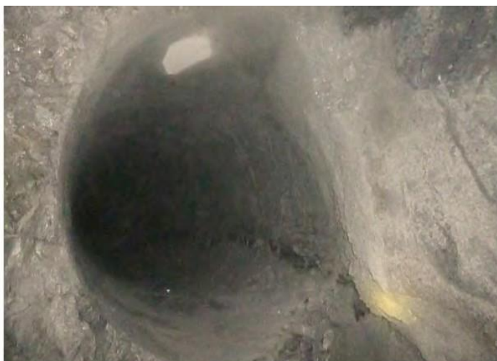
Слика 8. Финален изглед на ускоп изработен со машина за ускопно пробивање
