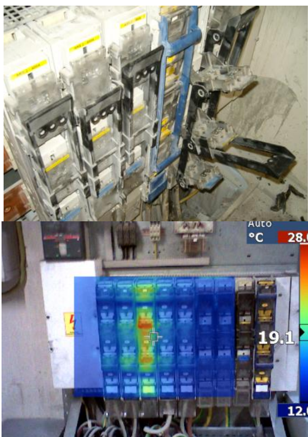
Слика 9. Слика со термална камера по извршена замена на оштетени постолја за осигурачите стопени поради голем преоден отпор. Се гледа нормална температура.
