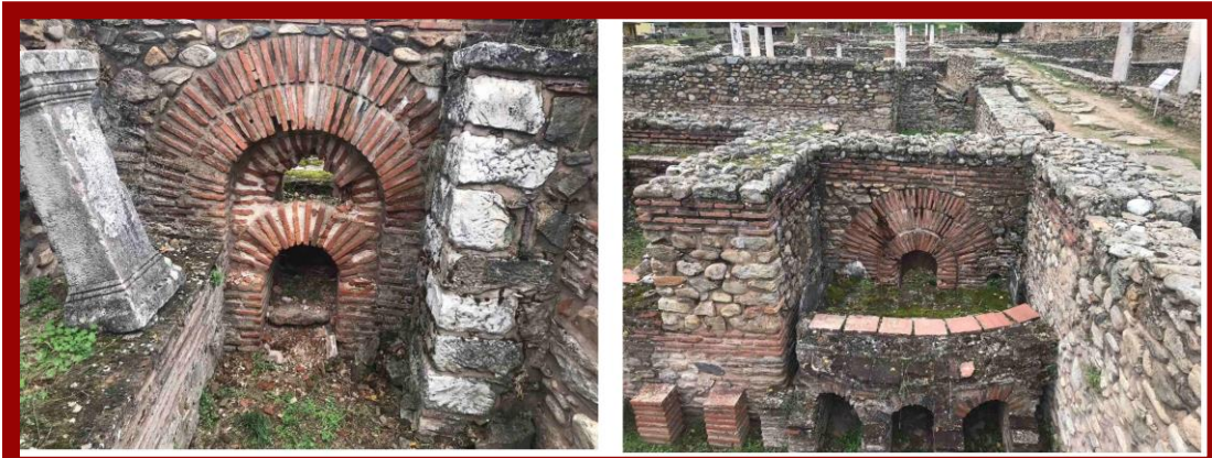
Сл. 4 и сл. 5. Северен фурниум, источна и западната фасада со ложиште, на римската бања во археолошкиот локалитет Хераклеја.
